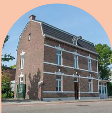
Hospice De Mantelhof Pijnsweg 38 Heerlen
